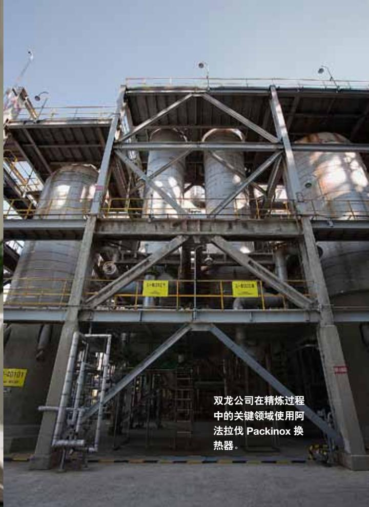
双龙公司在精炼过程中的关键领域使用阿法拉伐 Packinox 换热器。
