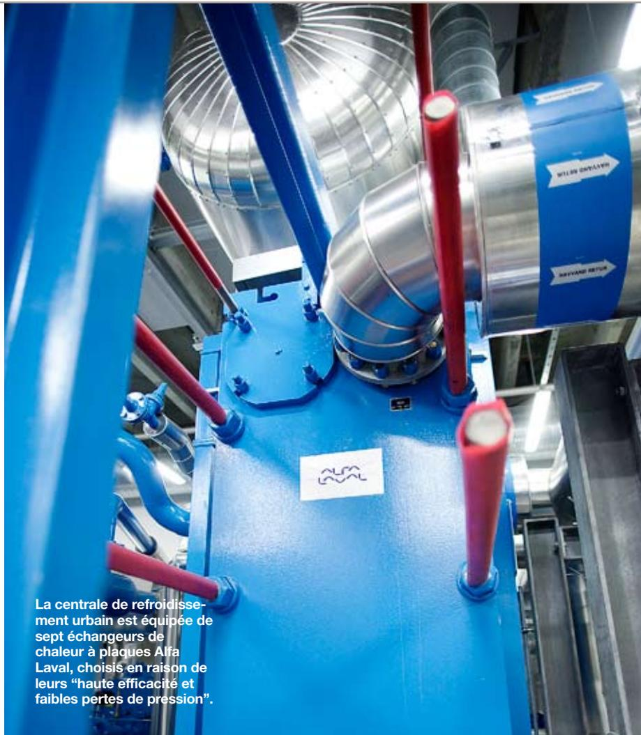
La centrale de refroidissement urbain est équipée de sept échangeurs de chaleur à plaques Alfa Laval, choisis en raison de leurs "haute efficacité et faibles pertes de pression".
